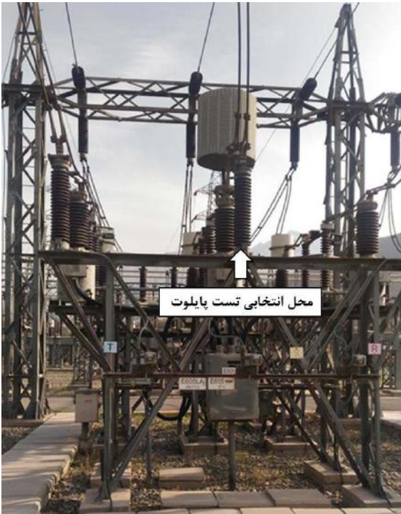
محل انتخابی برای انجام تست پایلوت پوشش در سطح ایزولاتور PT در خط محلاتی پست ازگل
