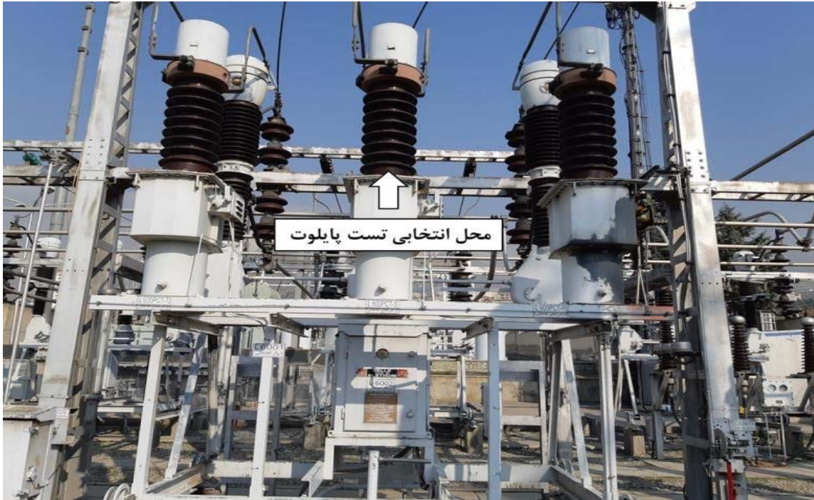
محل انتخابی برای انجام تست پایلوت پوشش در سطح ایزولاتور PT در خط محلاتی پست ازگل
