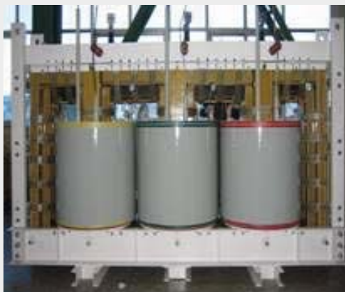
ترانسفورماتور ابررسانایی HTS
